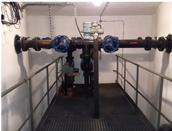
Zdjęcie 2: Lokalizacja armatury w nadziemnej części komory zasuw.
